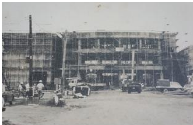
建設中の校舎（正面は昇降口）
